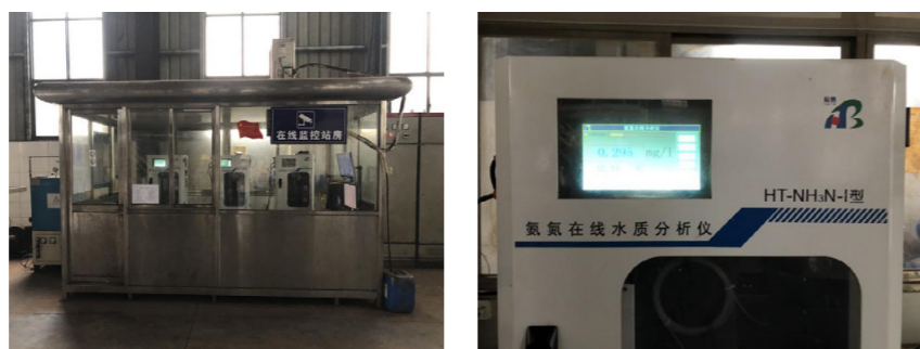
公司安装监控及废水在线监测设备，并与省市生态环境部门联网
